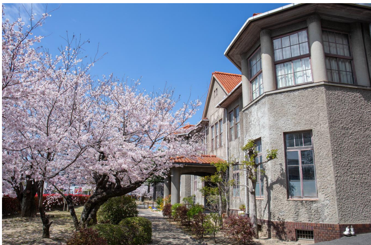
倉敷中央病院 南玄関周辺 Photo by Imamura Takashi
