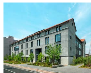
周囲に緑を配し、大きな窓を設けた建物。リラックスした空間で健診を受けられる
