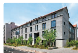
倉敷中央病院附属 予防医療プラザ
